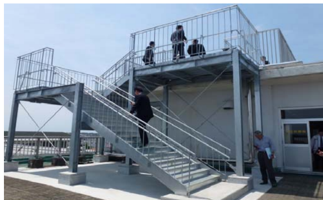
写真5. 津波から命を守る避難階段の整備
