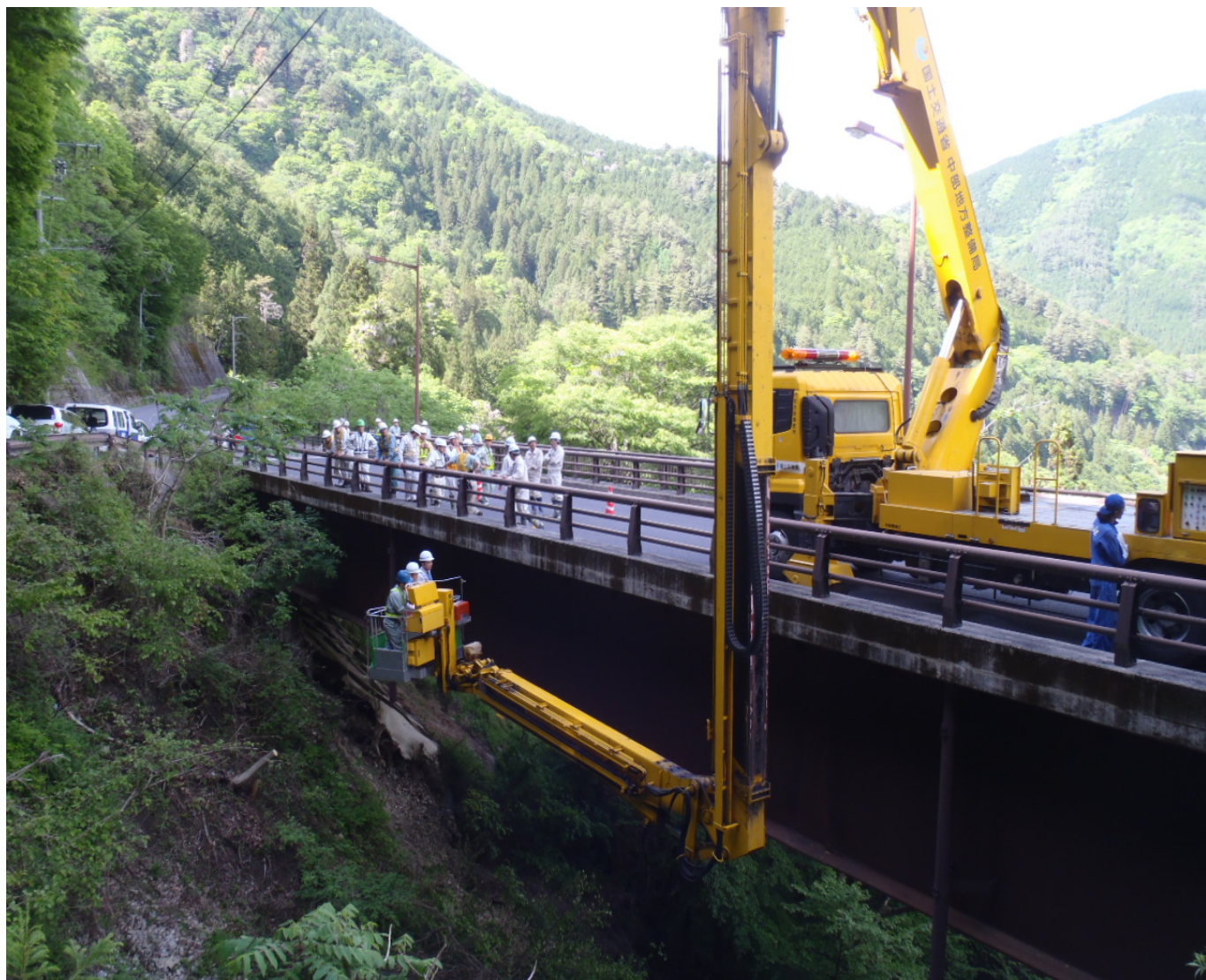
【橋梁点検車を使った橋梁点検実施講習風景】
