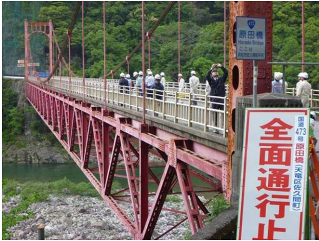
土研・国総研による現地調査
