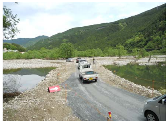
河川内緊急用通路の利用状況
