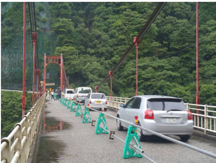
供用開始直後の原田橋
