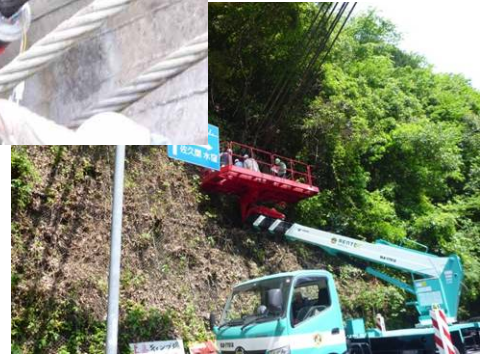
日本橋梁建設協会による現地調査
