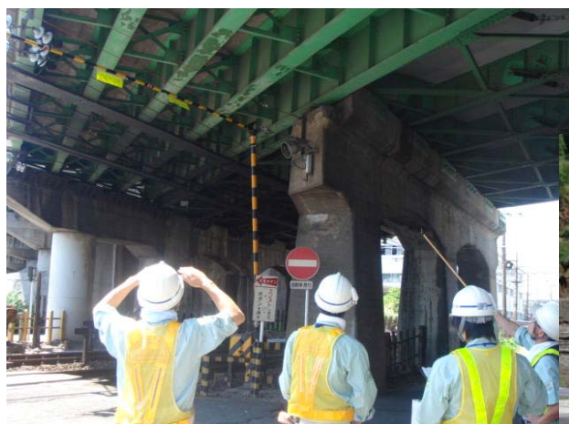
橋梁パトロール現場点検研修
