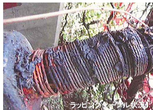
ケーブル破断した国道473号原田橋
