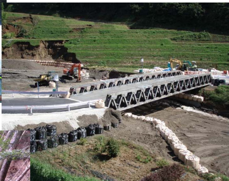
応急組立橋での迂回路設置
