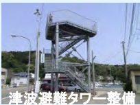
津波避難タワー整備
