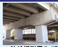
JR跨線橋耐震化（富士市）
