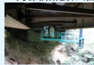
橋梁点検（瀬戸市）
