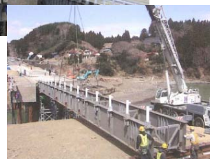
仮橋による流出橋梁の応急復旧 (日本橋梁建設協会)
