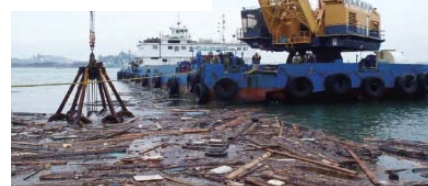
港湾内の障害物を取り除く建設業者
