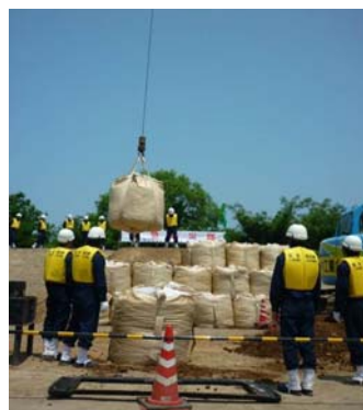
建設業者による大型土のう設置
