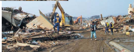
一刻も早い道路啓開作業を実施する建設業者
