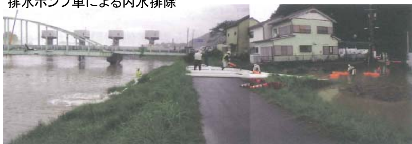
三重県紀宝町鮎田地区において、24h体制で排水ポンプ車による内水排除を実施(日本建設機械化協会中部支部他)
