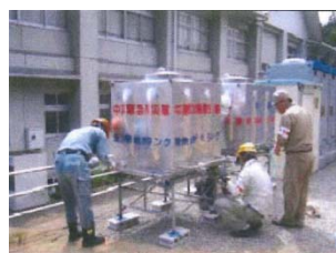
地元自治体の要望により、 給水タンクを地元中学校に設置 (日本道路建設業協会中部支部他)
