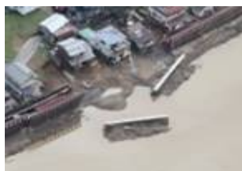
堤防決壊・氾濫
