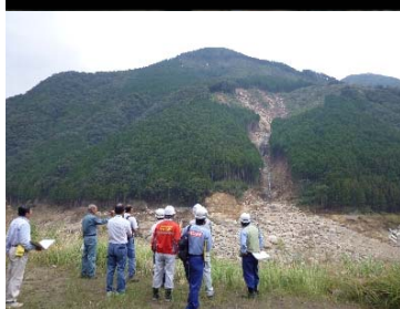
崩落危険箇所の調査
