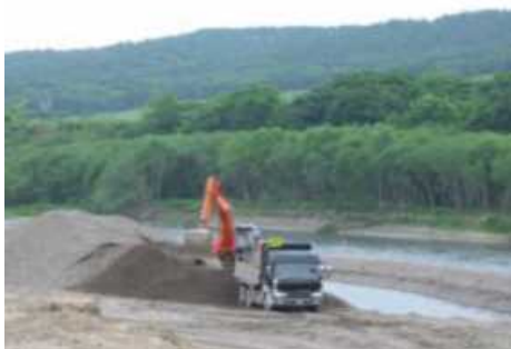
河道掘削した土砂を、
