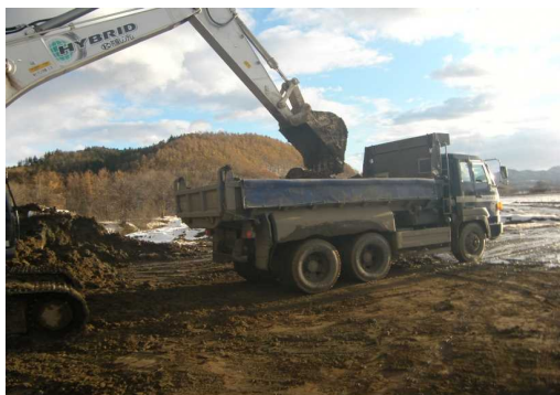
ダンプトラックへ積み込み、
