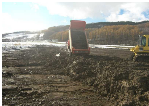
土砂が流出した農地へ運搬し、
