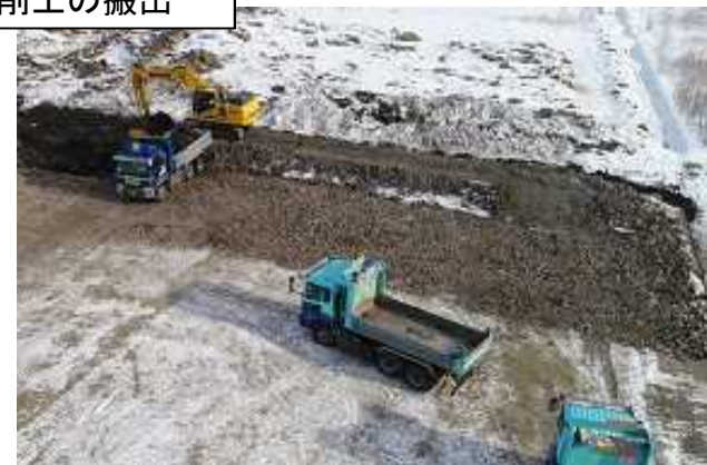
河川掘削土の搬出
