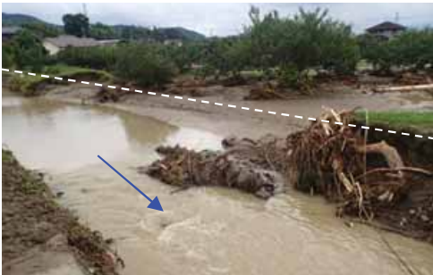
護岸の被災状況
