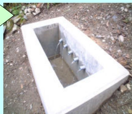
パイプの水をまとめる枺を設置します。さらにこの枺から沢に向けて、パイプで排水します。現在1分間に17リットル程の水が出ています。
