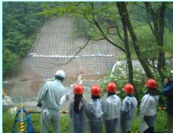
女高砂防堰堤工事現場を見学(田島建設)
