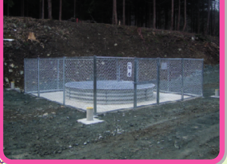
② 入谷地すべり対策工事
