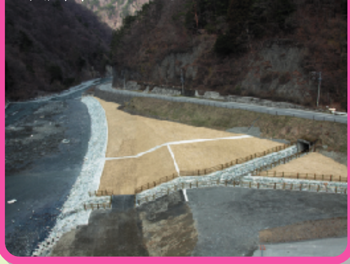
① 大河原床固工群工事
