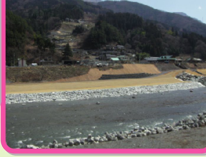
⑤ 大河原床固工群護岸工事
