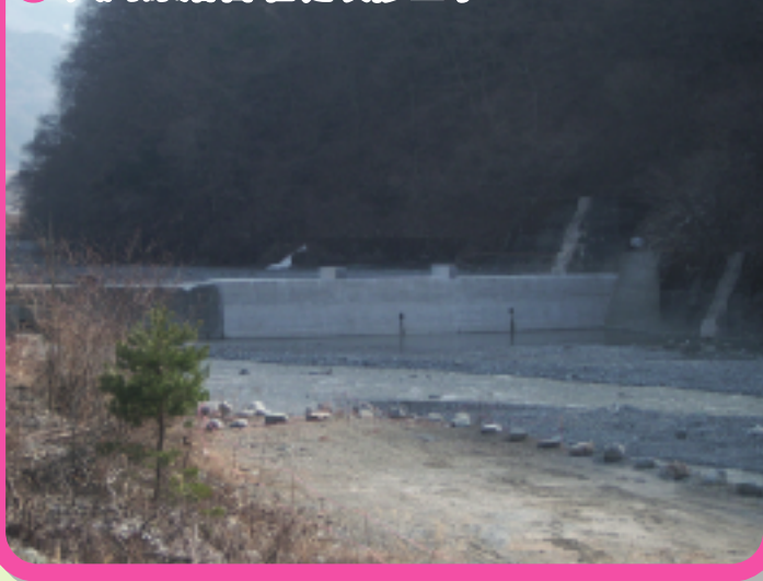
③ 大河原落合堰堤改修工事
