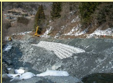
釜沢工区 2月末の現場状況
