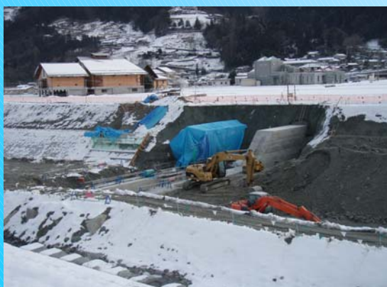
1月の現場状況
