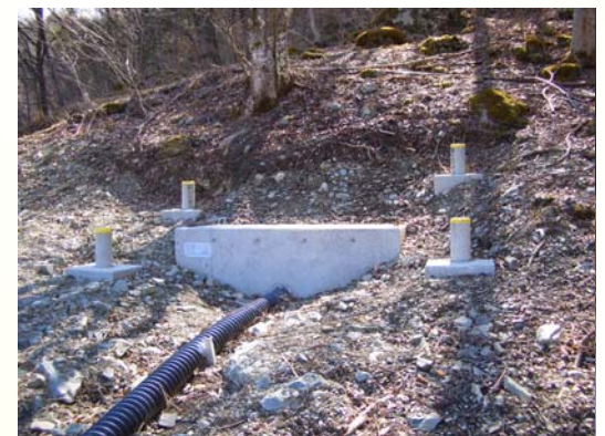
横ボーリング工
