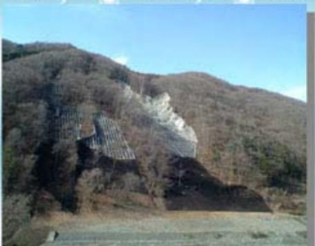
工事範囲が3箇所の崖根にまたがった地形で、高低差が最大で110mあり、ステップ数810段。総延長335mの作業通路を斜面に設置するのに大変苦労しました。夏は大変暑く、冬は例年より訪れるが早く、作業環境でも苦労しました。
