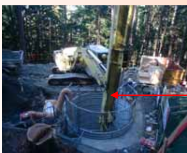
集水井工 施工状況
