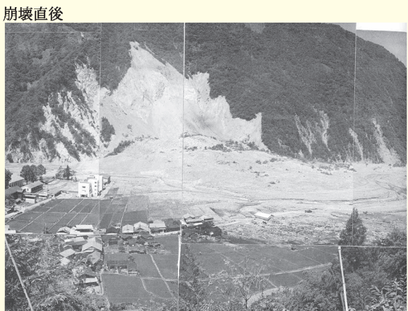
建設省中部地方建設局天竜川上流工事事務所 S36.6災害 大西山変貌写真集(1984.11)より
