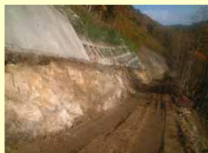
現在、中川村地先で流出土砂対策として堀破沢砂防堰堤を建設するための工事用道路を施工しています。工事箇所は上記地図の場所となります。
