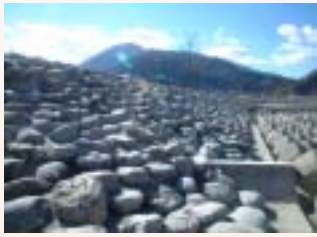
巨石張 60cm程の巨石を積みながら、裏側にコンクリートを充填します。ゆるやかな勾配ですので、川に楽に降りられます。
