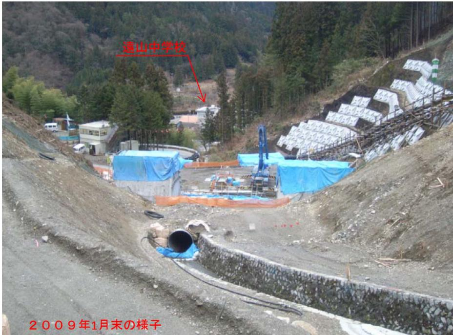
南信濃押出地区で土石流をとめる、主堰堤と副堰堤で構成される重力式と呼ばれているタイプの砂防堰堤を施工しています。
