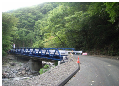
太郎橋施工完了
