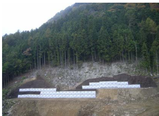
右岸側 アンカー工
