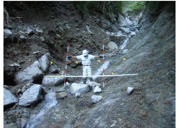
【土石流センサー設置状況】
