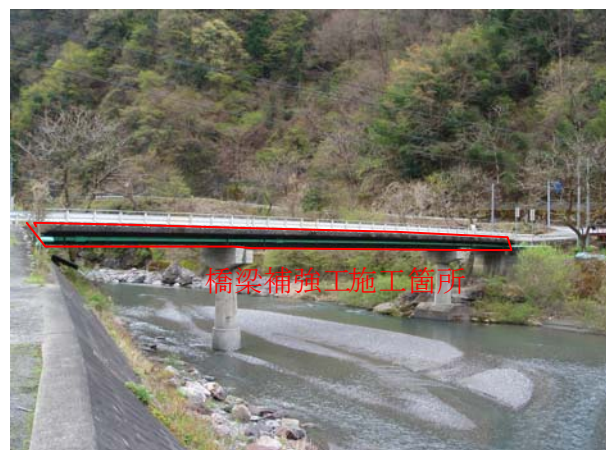
押出橋下流より望む
