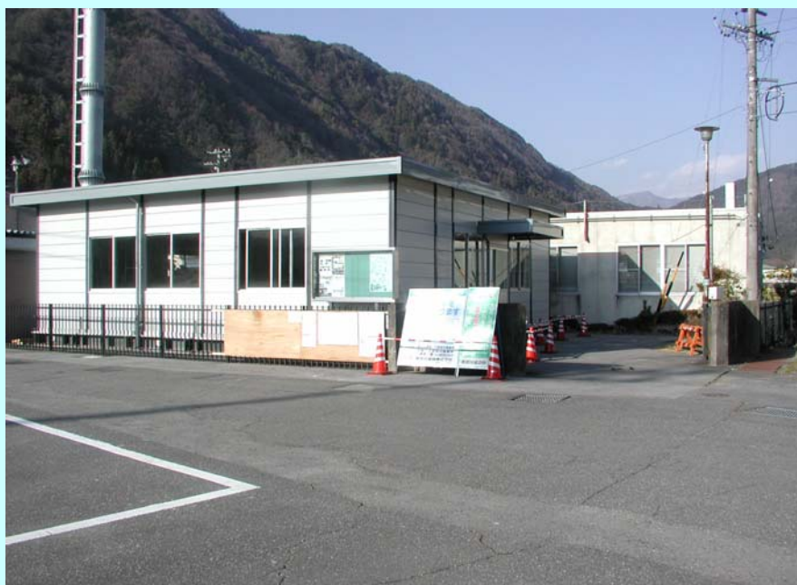
仮設事務所建方
