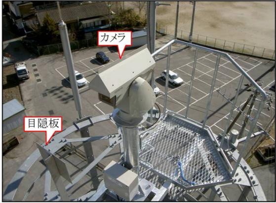
遠山川砂防出張所カメラ：20mの鉄塔上にカメラを設置、ご近所のプライバシー保護の為に目隠し板を設置しています。
