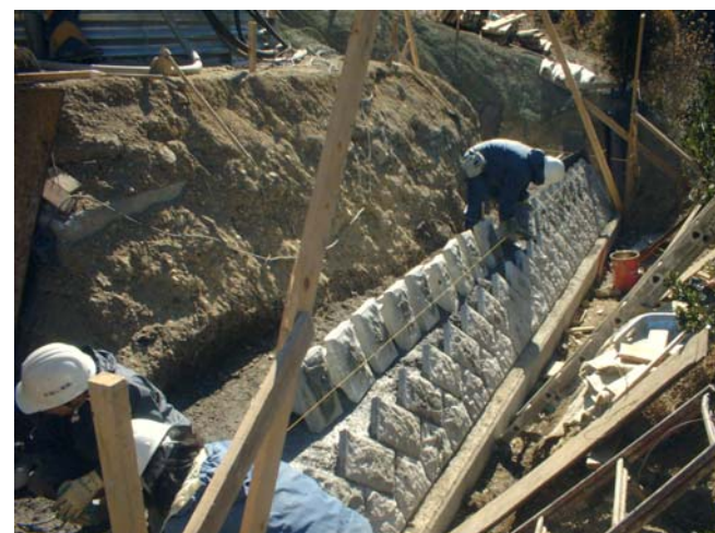
集水井周辺の コンクリートブロック積み施工状況
