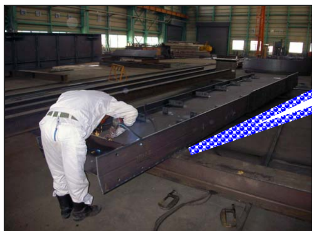
溶接作業の様子
