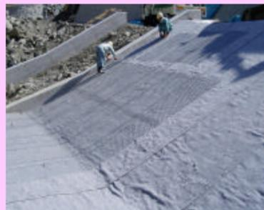
整形後の法面に、吸出防止材・ネットの順に布設していきます。
