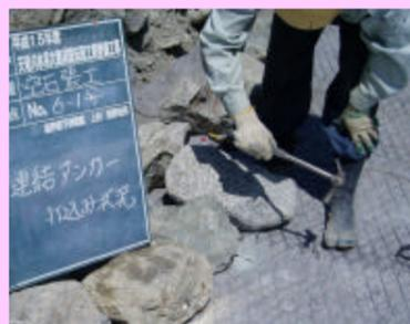
削孔した後ハンマーにて連結アンカーを石材に打ち込みます。
