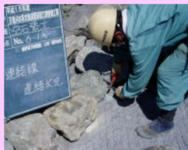
ステンレス線(2.6mm)を使用し連結アンカーとネットを連結します。連結後、石材間に土砂にて間詰します。
