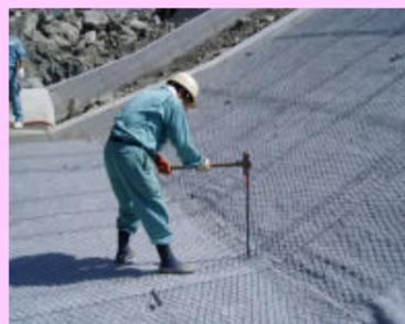
ネット布設後、押さえアンカーを打ち込み、ネットを固定します。
