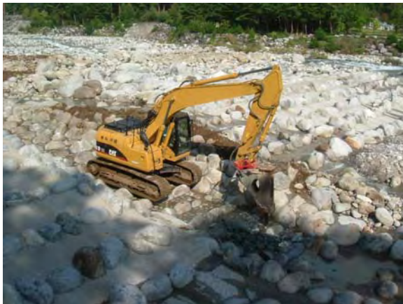
ブレーカによるステップの撤去
