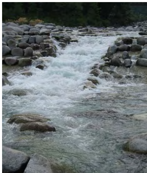
写真：太田切 11号床固工
