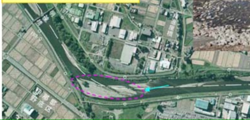
H18出水後の河床状態(H18.11撮影)
