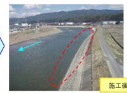
水面上に露出した根固工は河床面下に再整備
