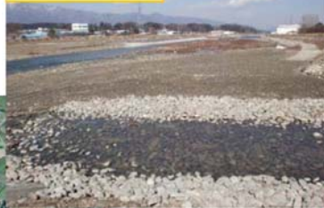
掘削後は、洪水後の航空写真の河床形状を復元させる
