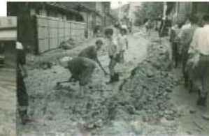
▲知久町商店街の浸水のようす
