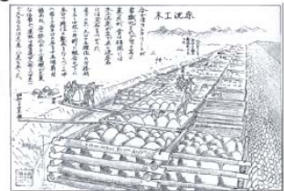
▲昭和24年頃の木工沈床による護岸工事のようす(三十年のあゆみより)
