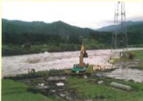
北島破堤箇所応急復旧状況
