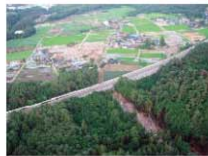
▲H18 年 7 月豪雨災害で土石流が発生した前沢川
