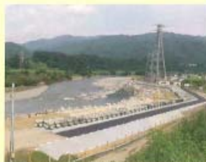
北島破堤箇所緊急復旧完成状況
