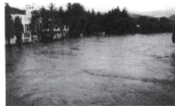
▲飯田市川路天電鉄 S58.9.29 床上浸水
