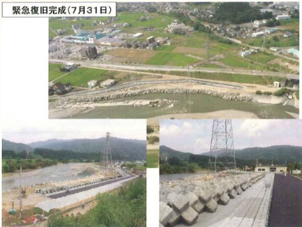
【上伊那郡箕輪町松島北島地先(天竜川204. 8k付近右岸)】
