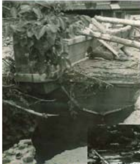
▲ひつじ満水（1715年）の再来といわれる鉄砲水にヒン曲げられた野底橋
