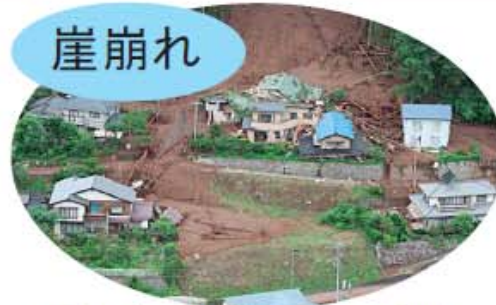
辰野町 赤羽中山 崖崩れの様子 (平成 18 年)
