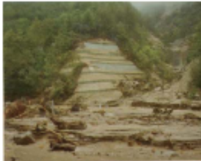
上郷町野底林道 土石流により林道決壊
