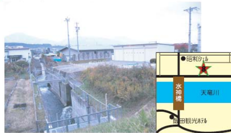
▲松尾地区の水防施設
