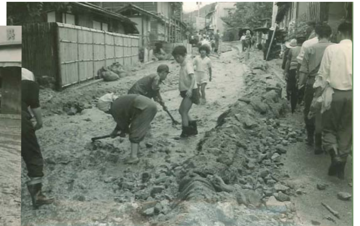
▲知久町商店街の浸水の様子
