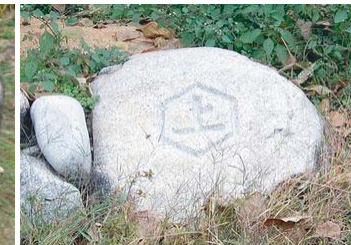
▲下の亀甲石、土地の境 界堤防等の距離をだす 基準点
