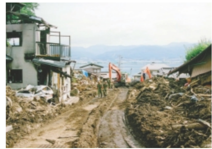
土石流によって押しつぶされた民家
