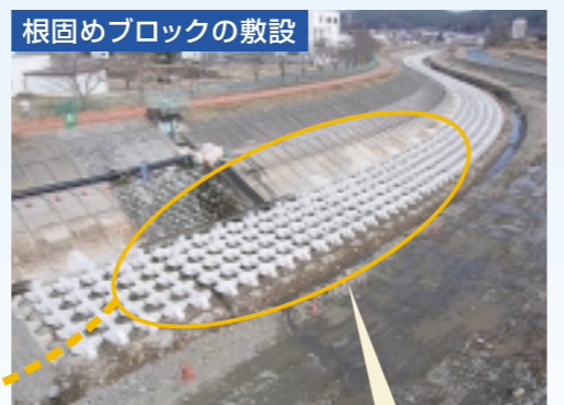
根固めブロックの敷設
