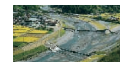
大河原床固工群(大鹿村)
