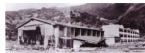
大西山の崩壊によって破壊された小学校。奥が校舎、手前が体育館。この災害の悲惨さが伝わる貴重な写真です。
