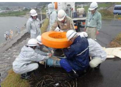
浮き輪をポンプに接続
