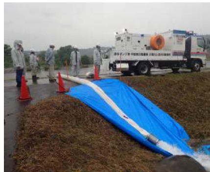
排水ポンプ車の排水
