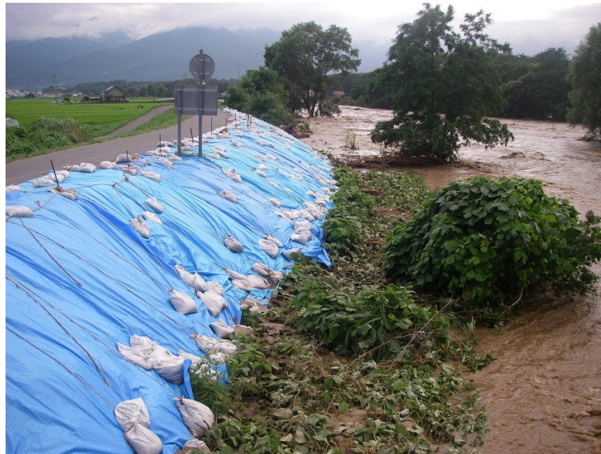
棚沢川合流部付近（伊那市） シート張り工（H18.7出水）
