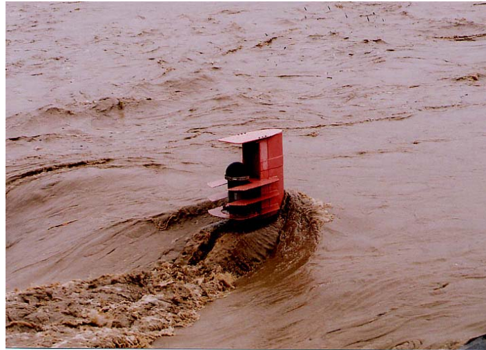
沢渡（伊那市）水位観測装置 （H18.7出水）
