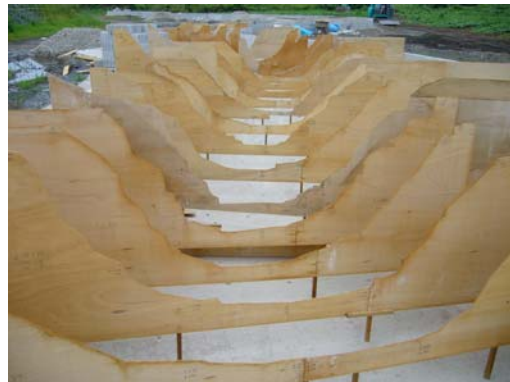
① 測量結果より横断板を作成・設置 (既往の河道横断測量データより)
