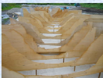
①測量結果より横断板を作成・設置
