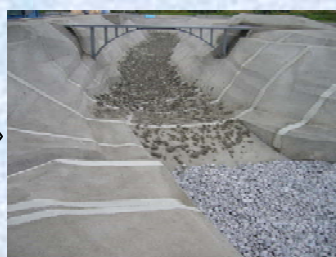
②モルタルで整形
