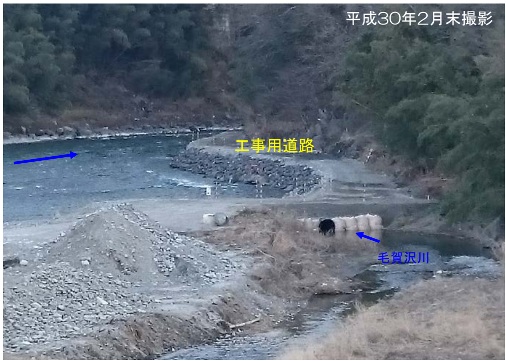
工事用道路設置完了の状況
