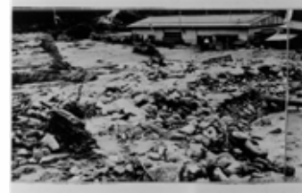
【支川の氾濫】田沢川(高森町)
