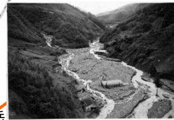
【支川の氾濫】北川(大鹿村)
