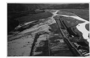
【支川の氾濫】新宮川(駒ヶ根市)
