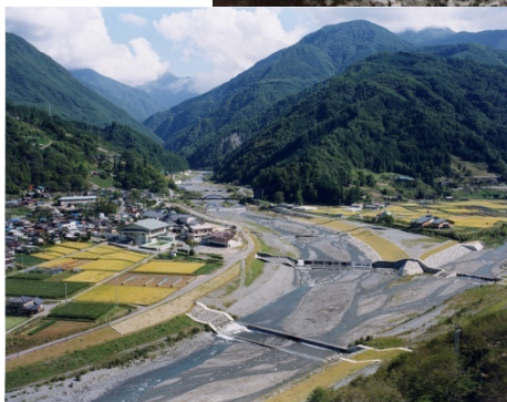
↑ 完成した砂防施設 (大鹿村大河原)
