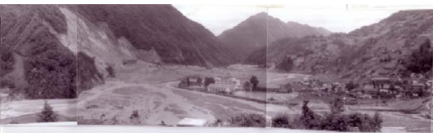
大西山崩壊状況
