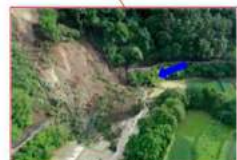
●喬木村加ヶ須 (土砂崩落)
