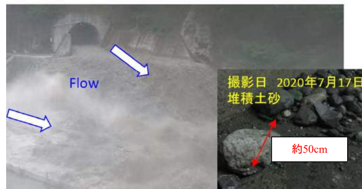
吐口部の状況(7/1 11時頃 放流量約170m 3 /s)
