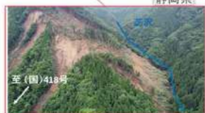
●天龍村足瀬 (土砂崩落)
