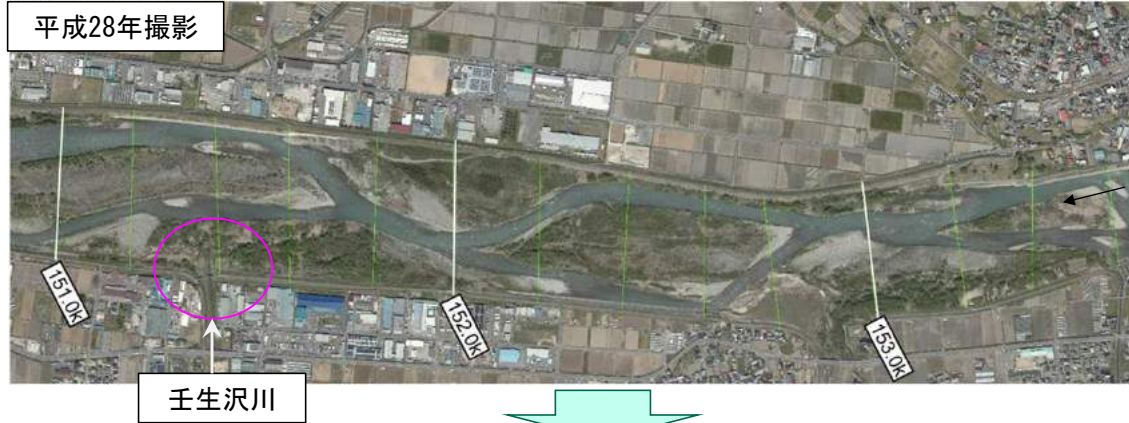
被災箇所②(天竜川左岸151.4kp)
