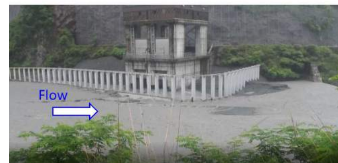
呑口部バイパス運用直後の状況 (6/30 16時頃 流入量約100m 3 /s 約EL614m)
