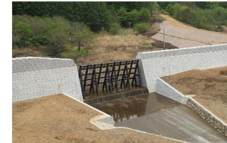
藤沢水無 鋼製スリット型砂防堰堤 (H23年度完成)(三峰川流域)
