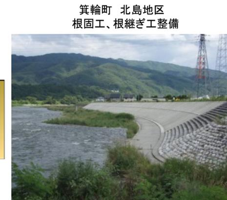
●急流対策(護岸・根固工)実施箇所
