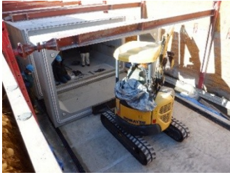
公共下水道（雨水）の整備 （長野市 更北南部 1号雨水幹線）
