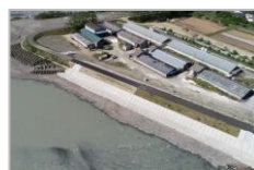
堤防整備 (富田村 大久保地区)
