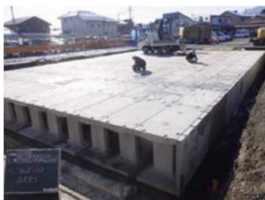
公共施設に設置されている地下貯留施設
