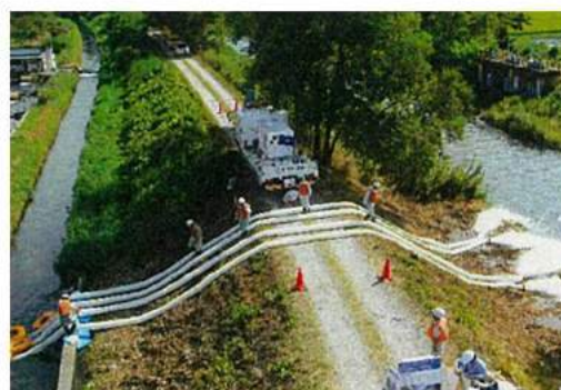
排水作業状況
